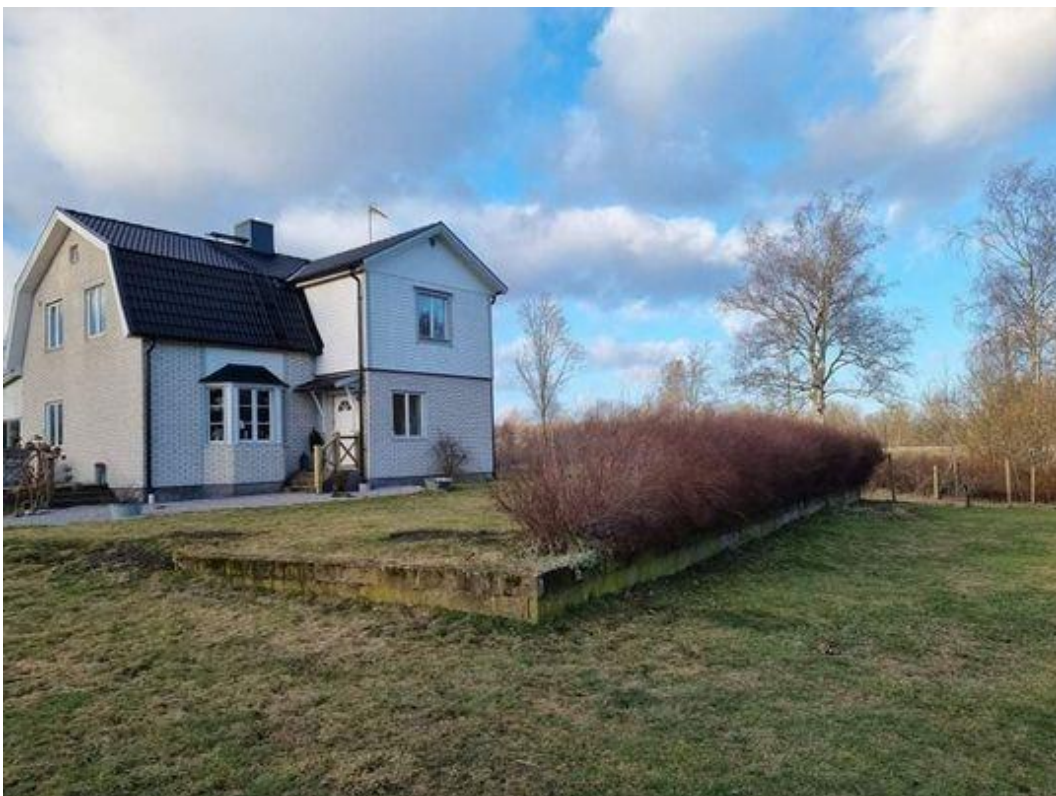
Figur 3. Boningshus med stödmur öster om huset.
