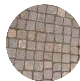
Smågatsten 9/11 används på minnesplatsen för att skapa mönster
