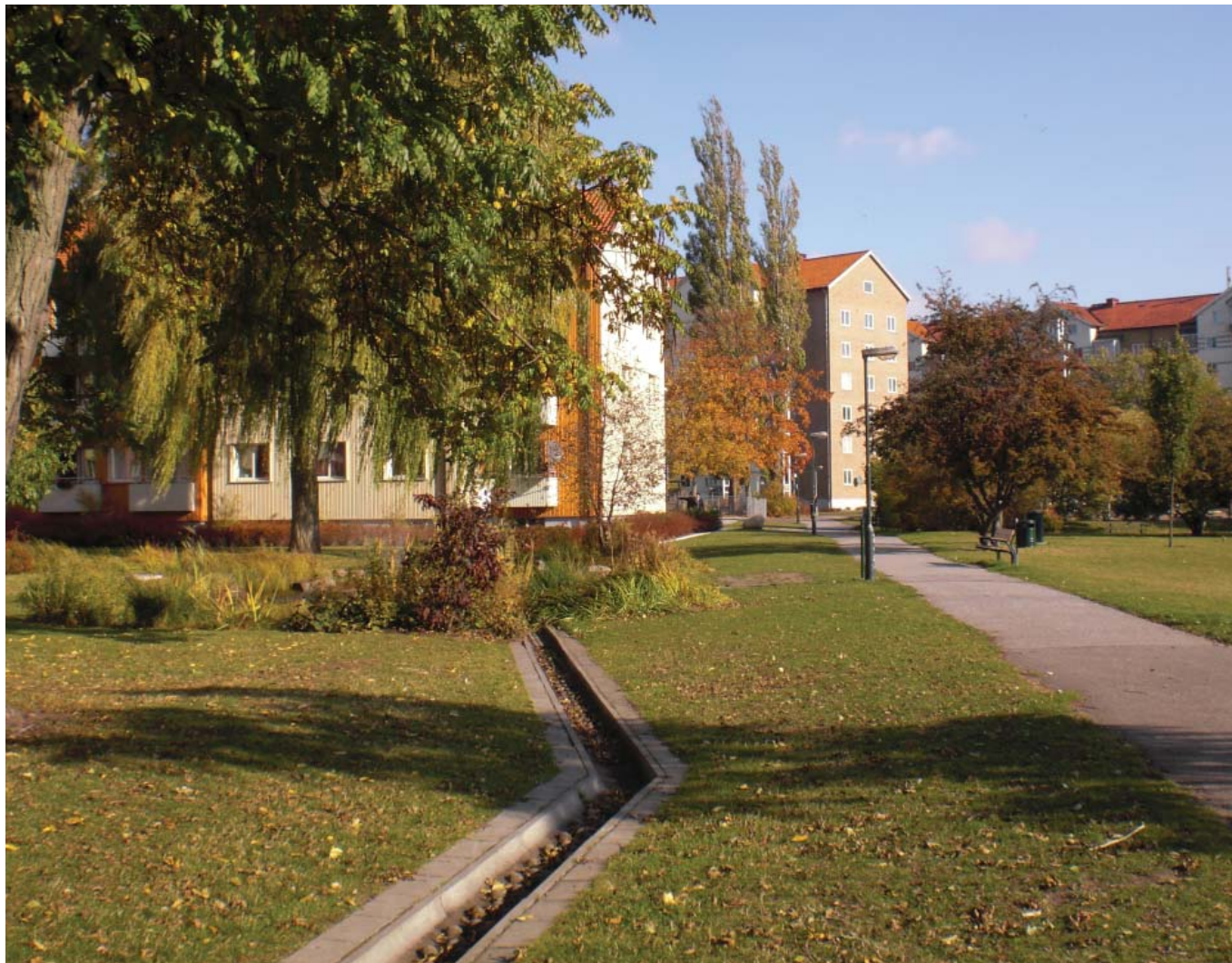
Figur 30. Det öppna dagvattensystemet är konsekvent utfört och väl integrerat i bostadsområdet Augustenborg, Malmö.
