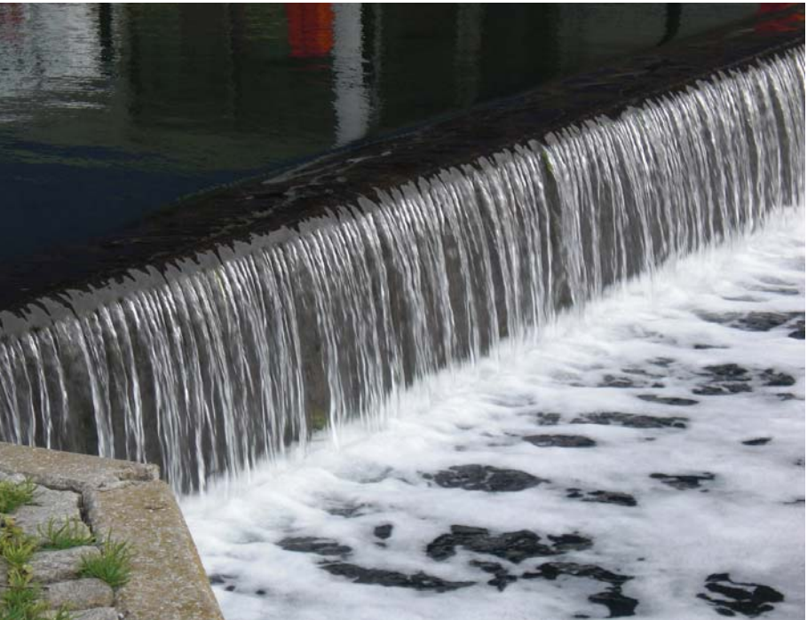
Figur 17. Vattenfall i damm syresätter vattnet.
