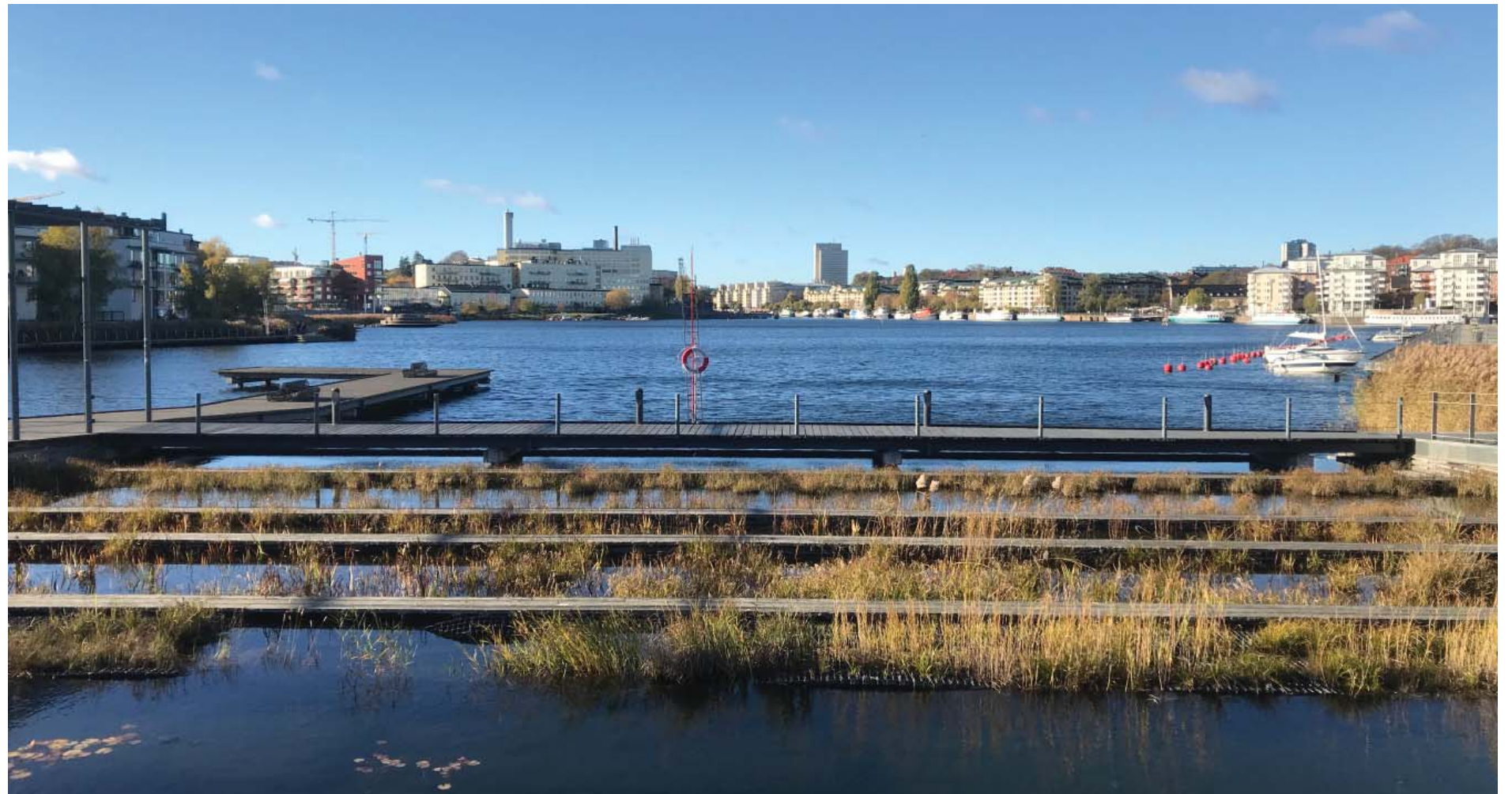
Figur 18. Våtmarksväxter i översilningsyta i Hammarby sjöstad renar dagvattnet innan det släpps ut i Hammarby sjö, Stockholm.
