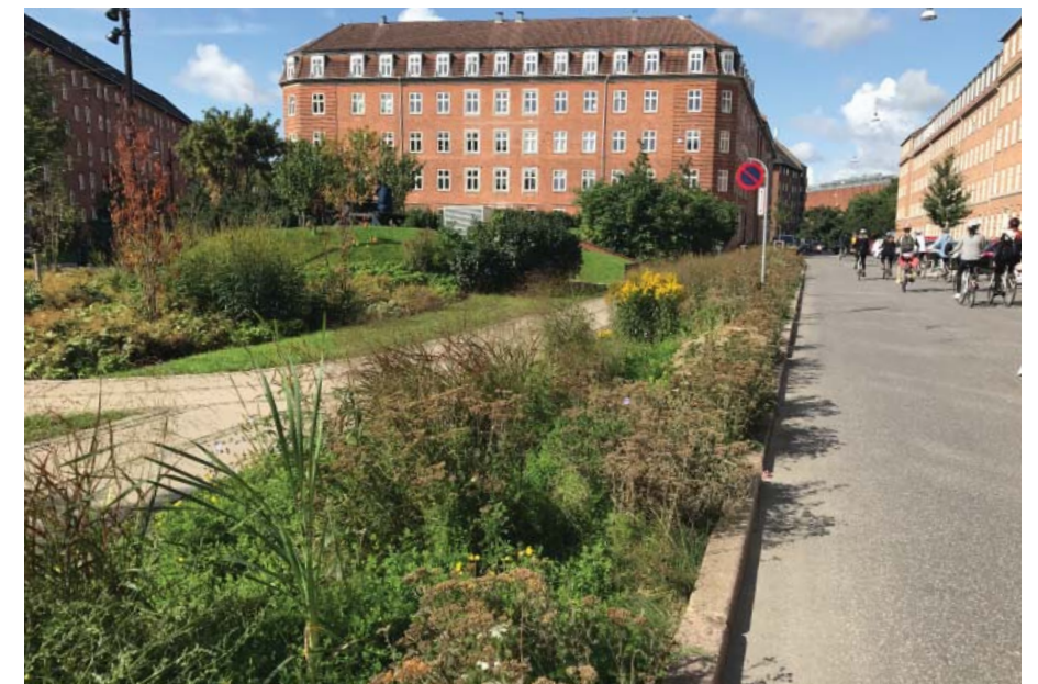
Figur 13. Den täta vegetationen i ett biodike ger högre reningseffektivitet och större fördröjningsförmåga – något som utnyttjas i Amerikansk dagvattenhantering, men även här på en gata utanför Köpenhamn.
