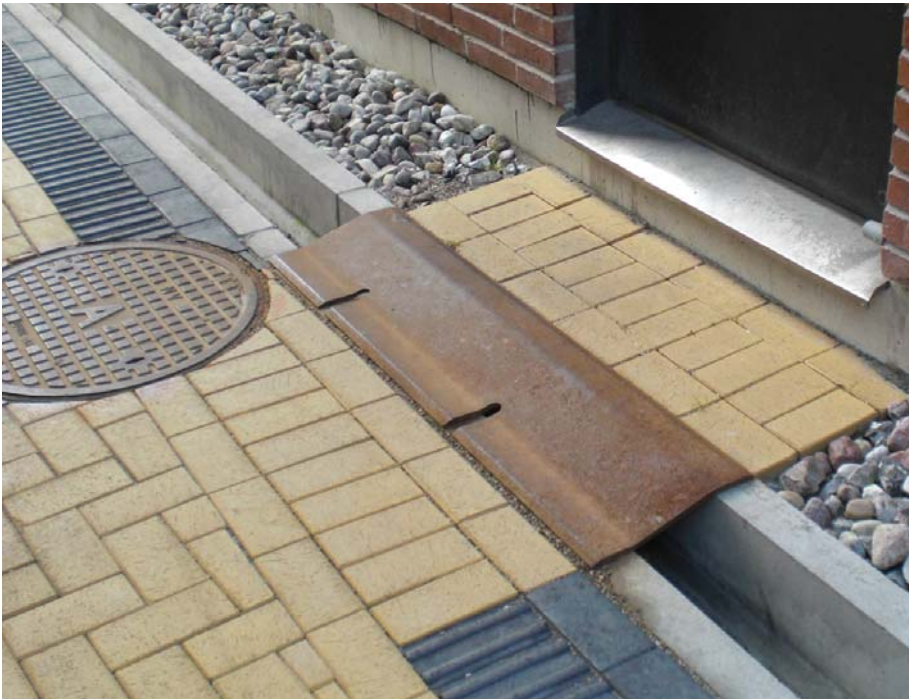
Figur 15. Kanaler kräver tillgänglighetsanpassning, här i form av täckplåt över kanal framför entré i Västra Hamnen, Malmö.
