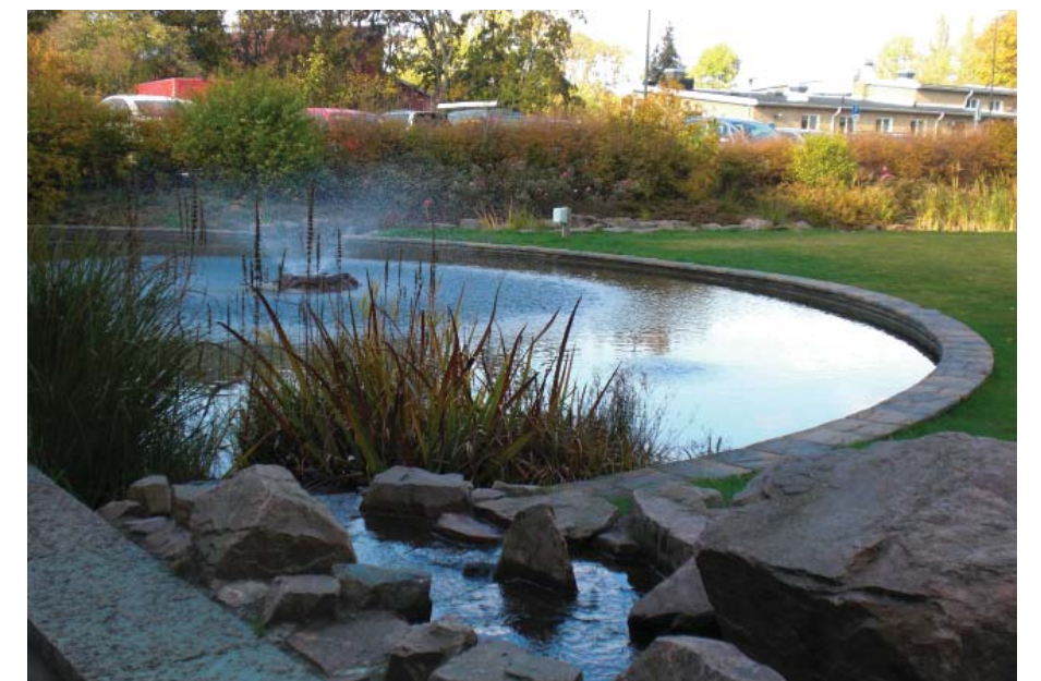
Figur 10. Dammar kan användas i olika syfte. Här är den inte bara en viktig del av det öppna dagvattensystemet, utan även ett uppskattat inslag och gestaltningselement på bostadsgården. Augustenborg, Malmö.
