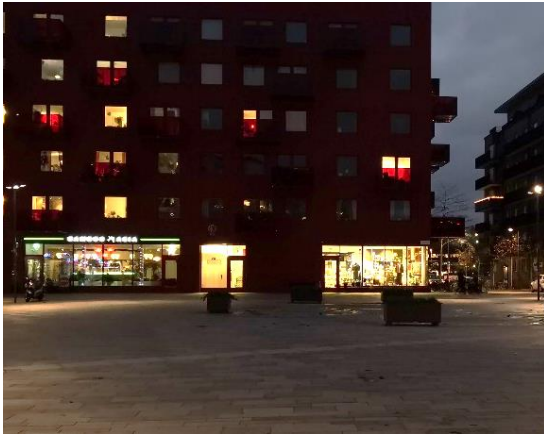
Figur 18 –. Bristande belysning vid området utanför södra byggnaden.
