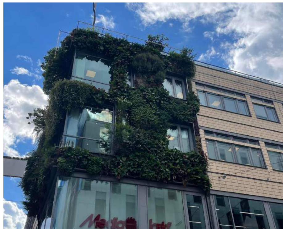
Figur 9. Foto av en levande vägg i centrala Stockholm.
