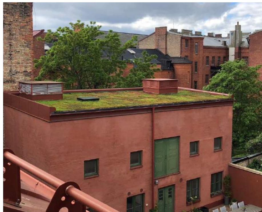
Figur 11. Sedumtak som lagts på befintlig äldre byggnad, i centrala Malmö
