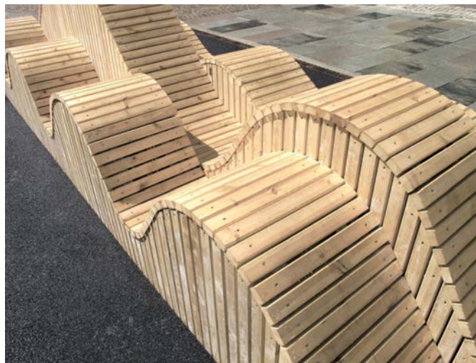
Figur 10. Ur förvaltningshänseende så måste vandalisering tas i åtanke, vilket ledde till en moduldesign där individuella delar kan bytas ut (Kling et al. 2016). © 02landskap/Mats Samuelsson
