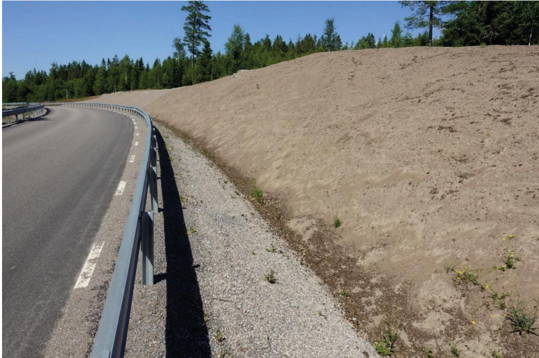
Figur 2. Ett sidoområde som utformats med gynnsamma förutsättningar för vegetationsetablering, då slänterna klätts med finkorniga massor som innehåller vattenhållande egenskaper. Fotografiet taget av Mats Lindqvist.
