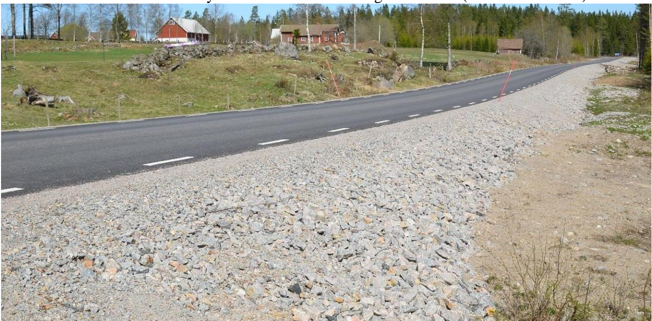
Figur 1. Fotografiet belyser, enligt Lindqvist, när hänsyn till biologisk mångfald inte tagits vid anläggningen av vägen. Vägens innerslännt är klädd med grovt stenmaterial, vilket missgynnar växtetablering. Fotografi taget av Mats Lindqvist.
