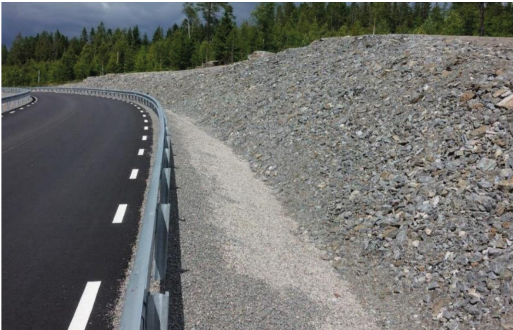
Figur 4. Ett sidoområde som utformats med ogynnsamma förutsättningar för vegetationsetablering, då slänterna klätts med grovkorniga massor. Fotografi taget av Mats Lindqvist
