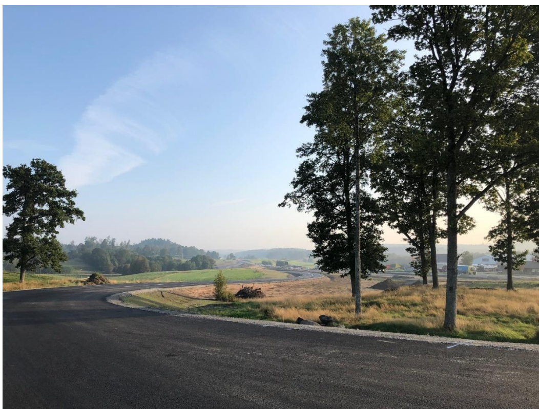
Figur 3. En väganläggning som utformats med hänsyn till landskapsanpassning. Vägen följer terrängen i omgivande landskap, samt har vegetation i slänterna. Fotografii taget av Anton Djurberg, Trafikverket.
