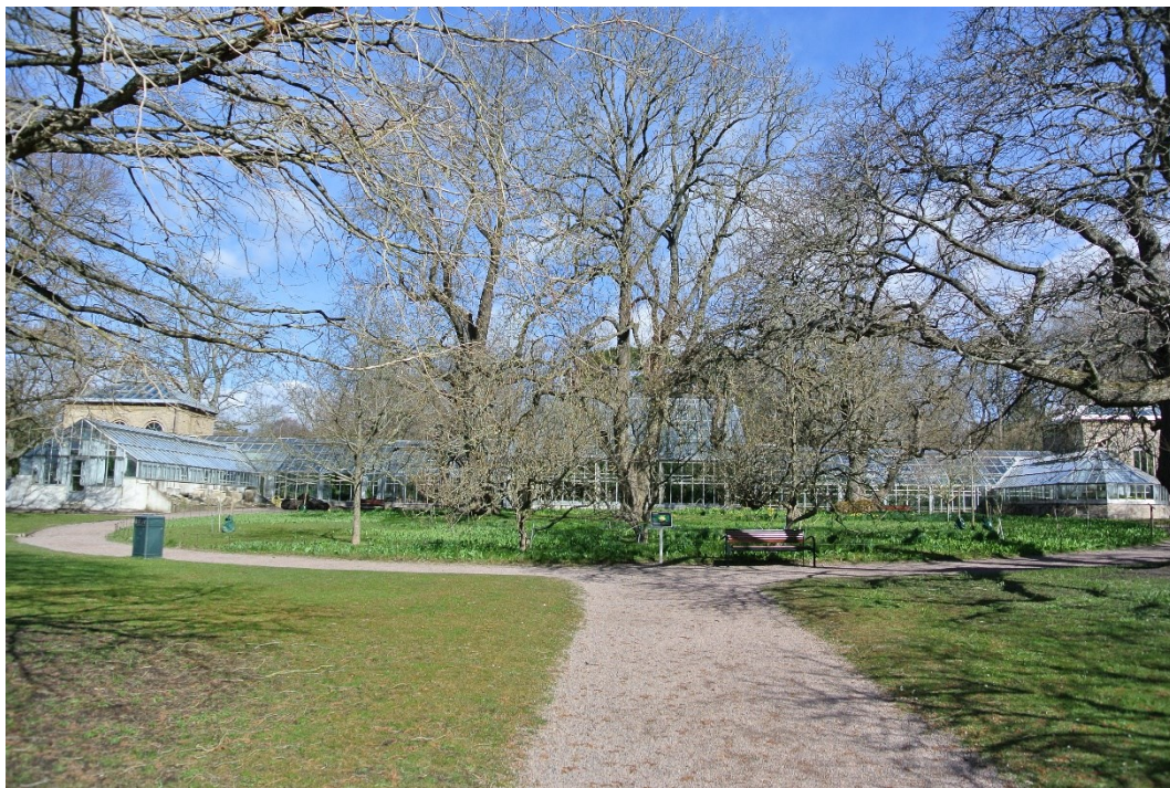
Figur 18. Växthuset i Botaniska trädgården i Lund, sett från söder, med ungefär samma utformning idag som när det byggdes under 1800-talet. I var ände av den långsmala byggnaden syns orangerierna i gult tegel.
