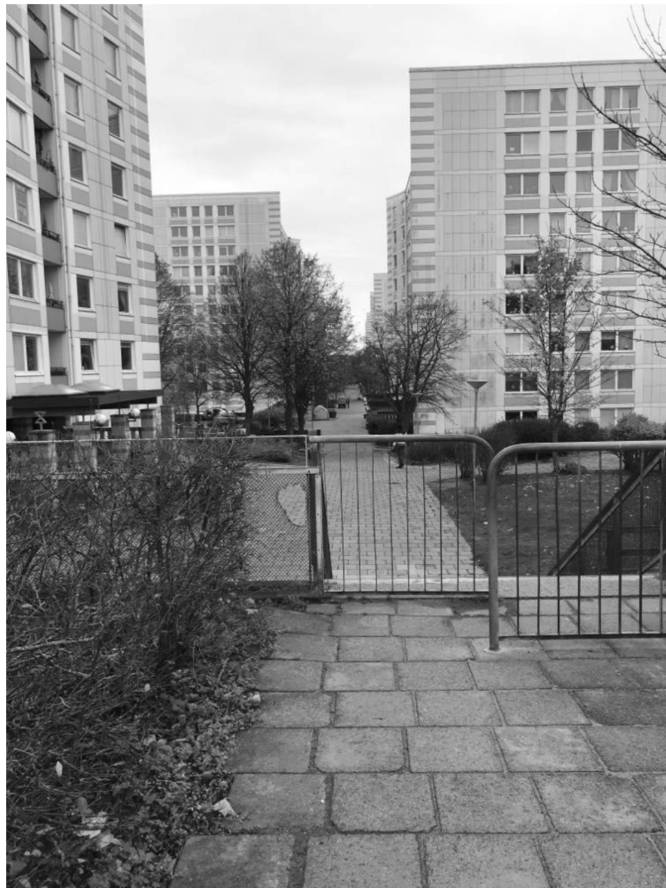
Figur 48. Säkerhetsavspärningar vid nivåskillnad i Almgården. (Foto: Zara Persson, 2021)
