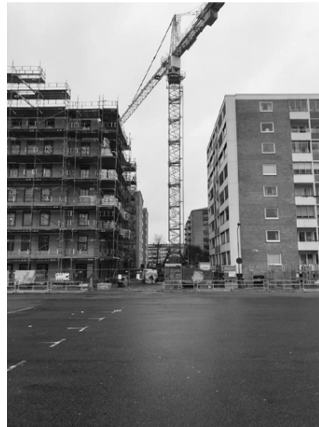
Figur 28. Förtätning i Katrinelund i Malmö. Den nya byggnaden skuggar ut den befintliga och förstör den struktur som bygger på öppenhet och ljus. (Foto: Zara Persson, 2022)
