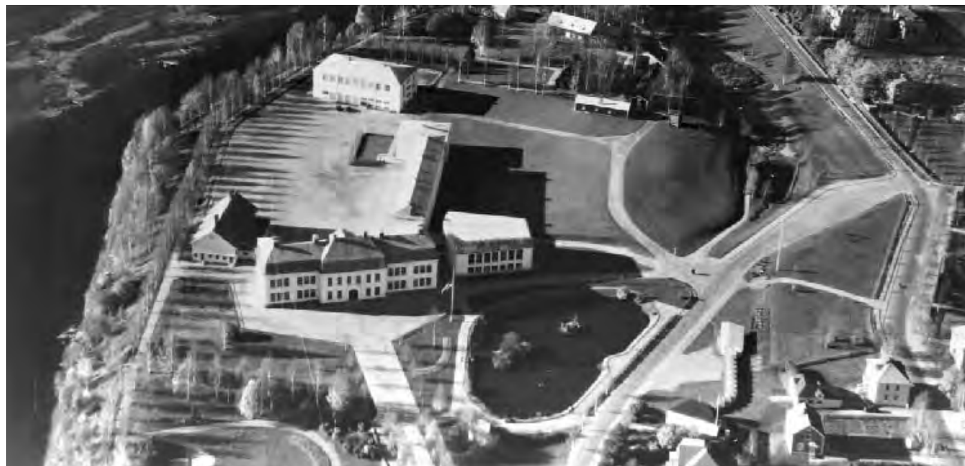
Figur 42. Flygfoto över Nordanåparken. De klippta gräsyterna utgör ett golv som håller samman parken. © Skellefteå museum
