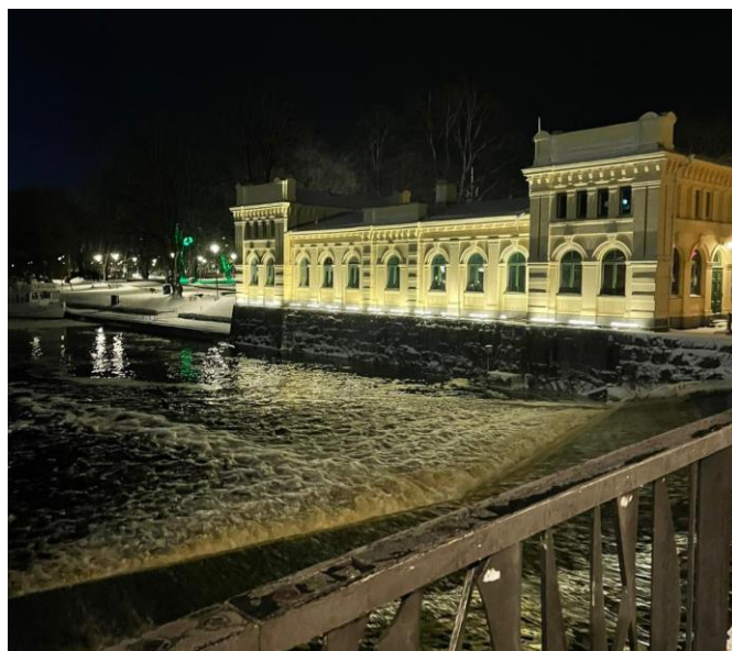
Figur 12. Pumphuset intill Stadsträdgården i Uppsala är en historisk byggnad med kulturellt värde och har en upplyst fasad. (Foto: Lindqvist 2022).
