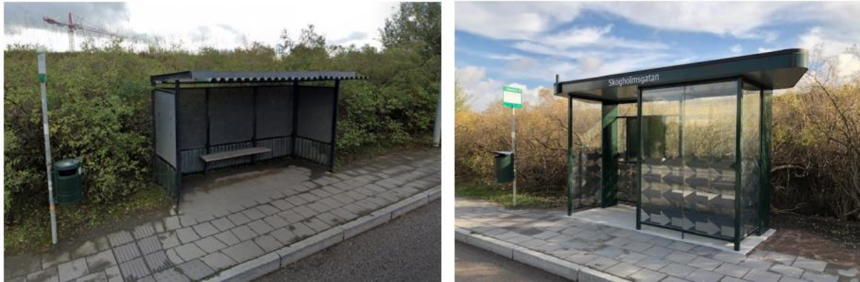
Figur 14. Hållplats utanför Storstadspaketets åtagande där upprustning påbörjats under 2021, men där planerad tillgänglighetsanpassning ännu inte färdigställts (författarens bild).
