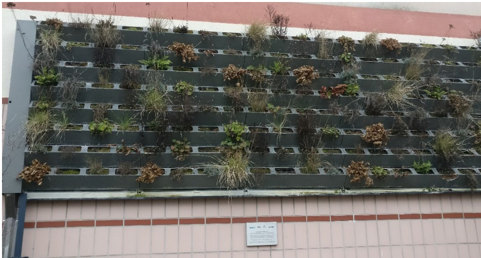
Fig. 15. Grön vägg nära Augustenborgs centrum. Foto: Författaren.
