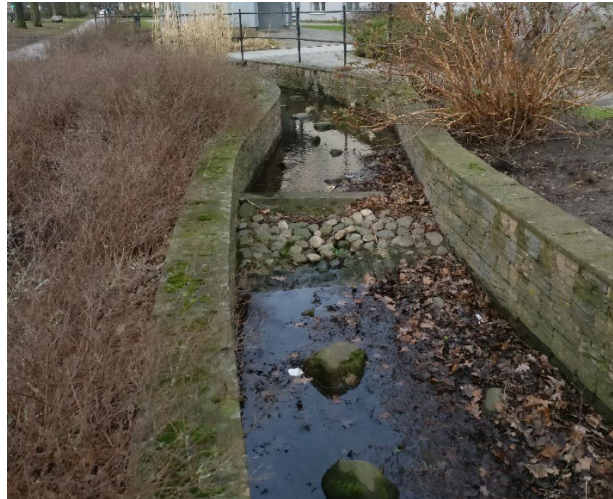
Fig. 16. Kanal med murade kanter. Foto: Författaren.
