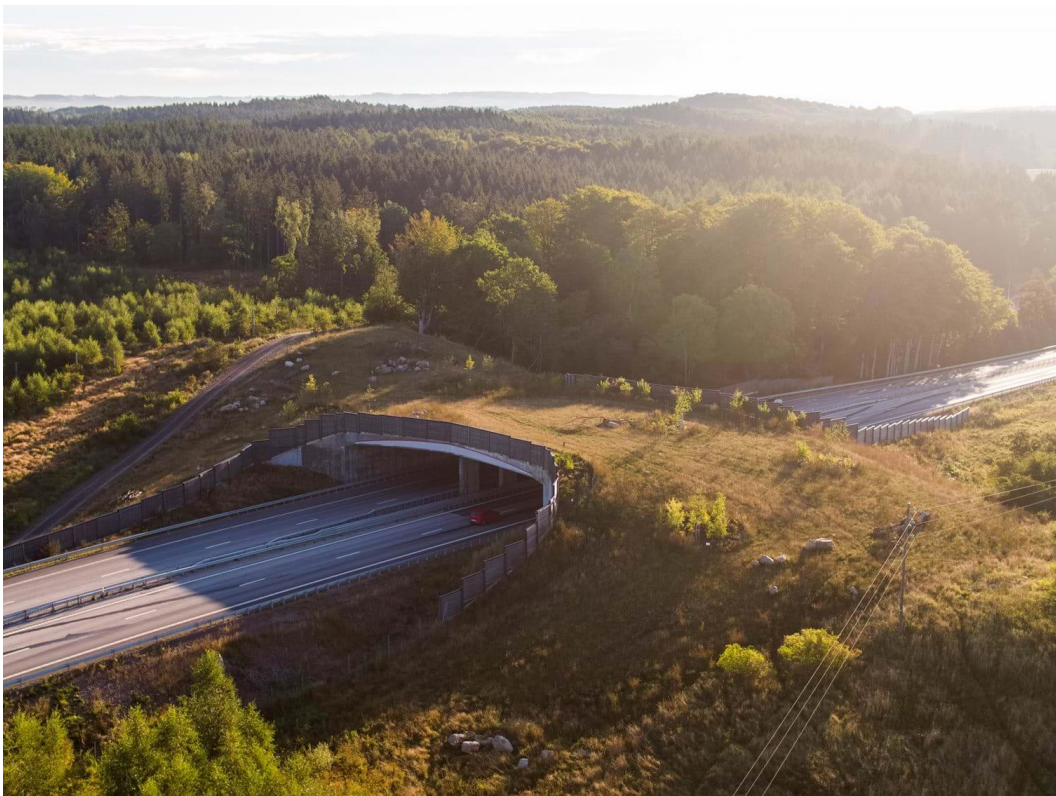
Figur 1: Ekodukt E65 (Tyréns, 2018). Beställare: Trafikverket. Ekodukt särskilt anpassad för kronhjort / Tyréns (tyrens.se) .
