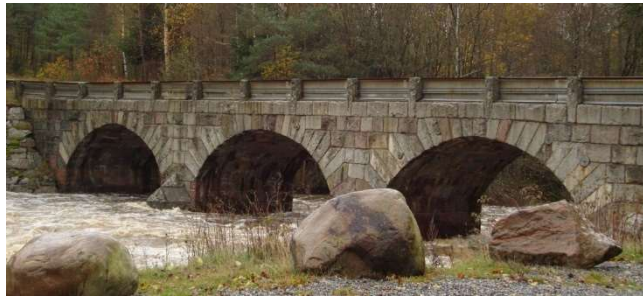
Figur 6 Stenvalvsbro Kvistrum (Riksantikvarieämbetet u.å)
