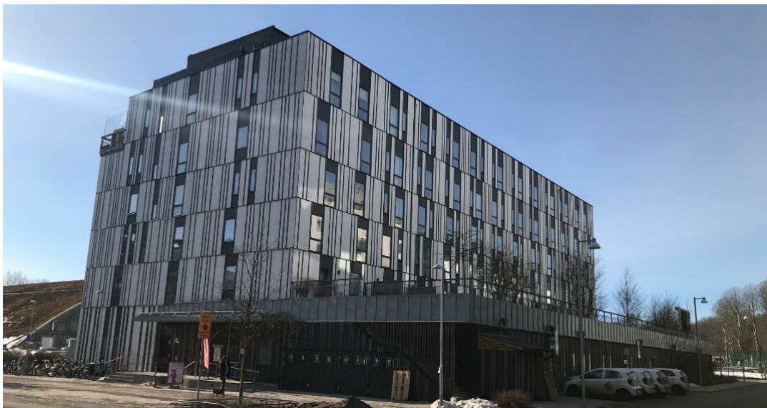
Figur 9: Kvarteret Smaragden från ögonhöjd, där vegetationen på taket inte är synlig. Foto: William Ekander 07-03-22.
