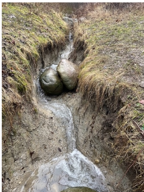
Figur 14. Vatten forsar i diket med erosionsskador.
