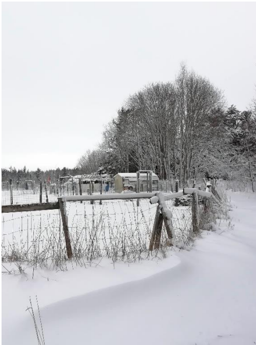
Figur 5. Staket som omringar kolonilotter. Detta kan anses skapa ett stökigt uttryck då det har tappat en del av sin stabilitet (Karlsson 2022-02-22).
