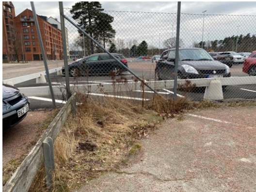
Figur 9. Vy över yta vid parkeringsplats
