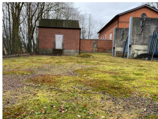
Figur 1. Vy över transformatorstationen
