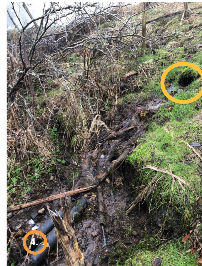
Figur 9. Visar nummer 4. Utloppet från dräneringsröret upp i slänten.
