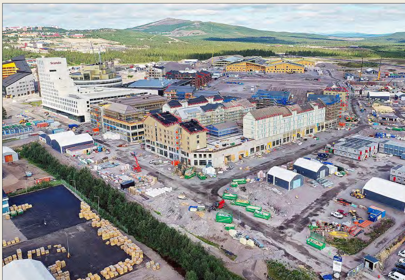
Figur 33. Nya Kiruna centrum under uppbyggnad. Foto: LKAB.
