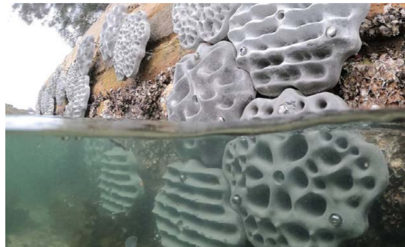
Figur 30. Foto på betongplattor monterade på en kajkant. Foto: Tillstånd av Stina Bertilsson Vuksan
