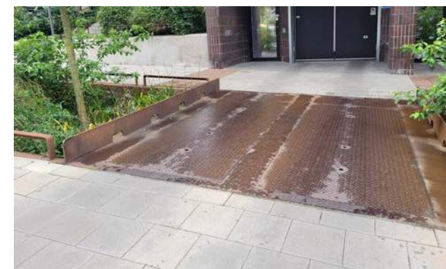
Figur 24. En övergång som tillåter dagvatten att passera ner i växtbädden.
