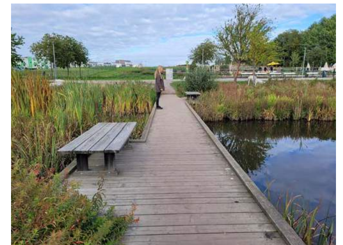
Figur 12. Bryggorna i Kyrkparken i Järfälla är upphöjda och ska kunna översvämmas vid kraftiga vattenflöden.
