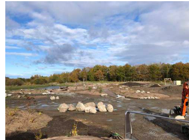
Figur 35. Pågående anläggningsarbete. Det gäller att “få till det stora landskapet”.
