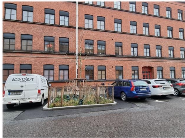
Figur 20. Bilden till höger visar regnbädden som takvattnet leds till.
