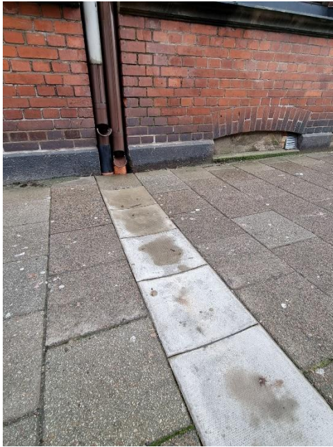
Figur 19. Bilden till vänster visar en rännal från stupröret till regnbädd.
