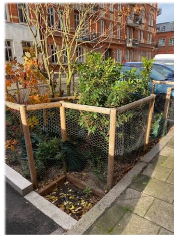
Figur 7. Bild till höger, sandfångets placering i regnbädden.
