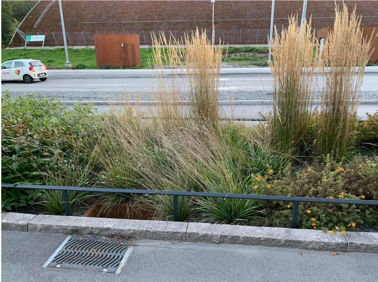
Figur 48. Regnbädd längs med Vårdsätravägen sett från cykelbanan. Notera inloppet som finns från både gata och cykelväg samt nivåskillnaderna. Foto: Sofia Andersson
