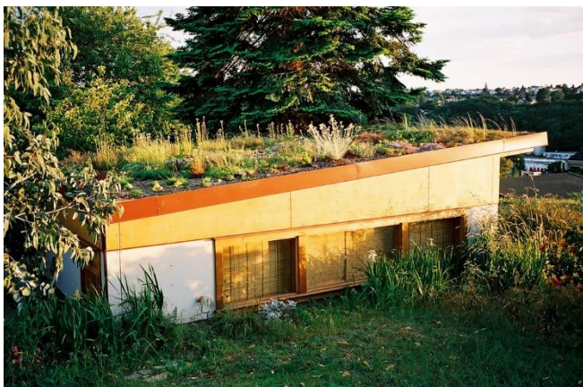
Figur 5. Frodigt grönt tak på mindre byggnad. Foto: "Green Roof Garage" av Rob Harrison via creative commons licens (CC BY-NC-ND 2.0) https://www.flickr.com/photos/66974085@N00/3288487594
