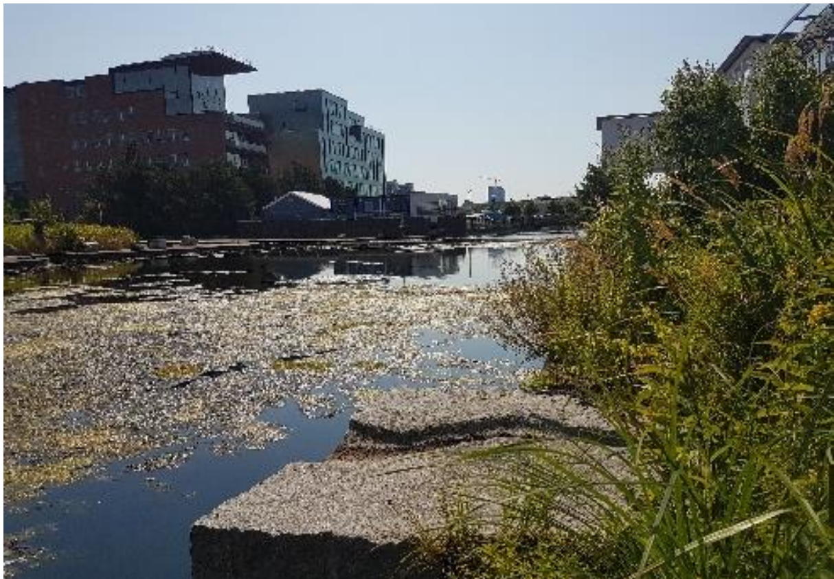
Figur 37. Dagvattnet leds via dagvattenkanalen in i de våtmarksliknande kammarna. Underst visas utloppet där vatten tillåts svämma över vid kraftigt regn.
