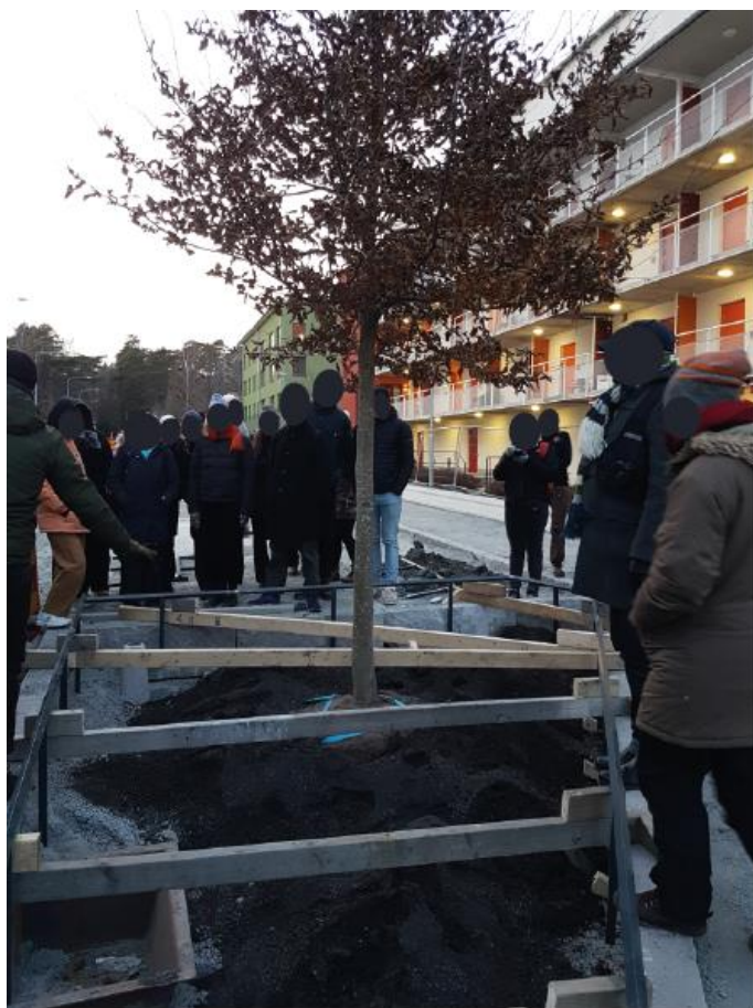
Figur 46. Regnbädd under konstruktion, inlopp syns till vänster i korrigerad stål. Foto: Zara Li
