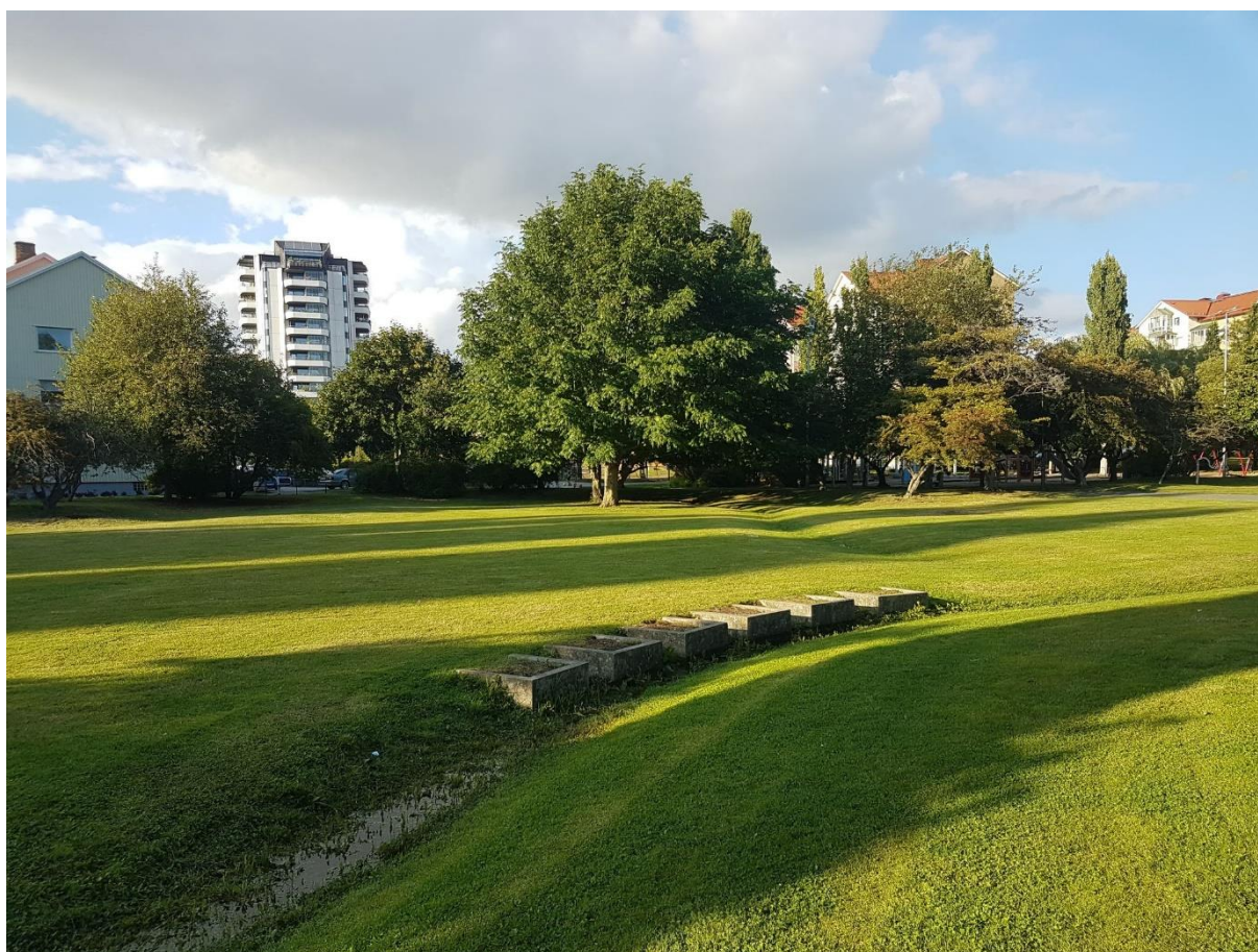
Figur 21. Svackdike bakom Augustenborgsskolan, Malmö. Kurvan är förstärkt mot erosion med dekorativa betongformer.
