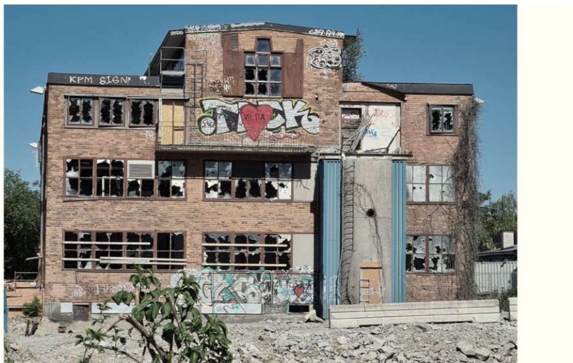
Figur 52. Nitrolackfabriken uppfördes 1944 efter ritningar av arkitekterna L.M. Giertz och Nils Tesch. Idag är byggnaden ett exempel på vandalisering och förfall som fått pågå i området under lång tid.
