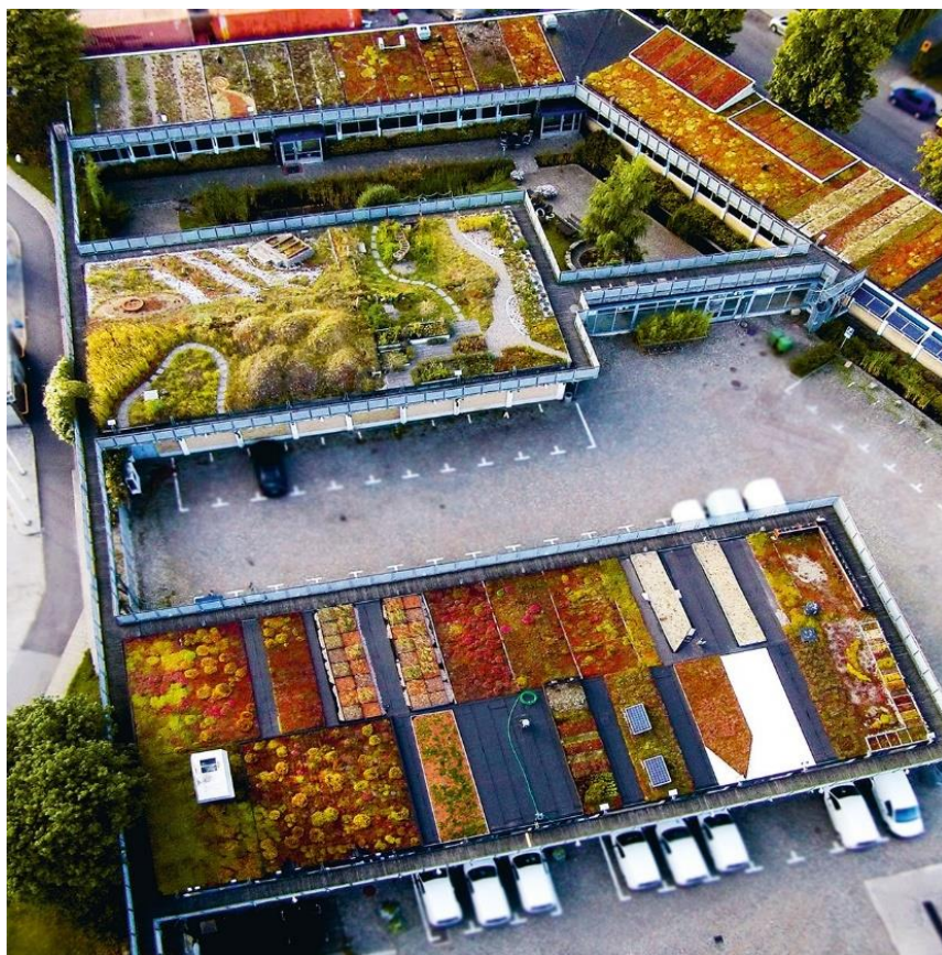
Fig.1 Extensivt och semi-extensivt grönt tak, Augustenborgs botaniska trädgård, Malmö. Foto: Jonatan Malmberg/SGRI.
