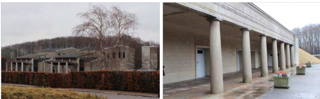
Figur 3. Foto byggnader Östra kyrkogården. Ellen Eriksson 2021. Bilden till vänster visar tvillingkapellen S:t Gertrud och S:t Knut. Till höger syns S:ta Birgittas kapell som är inbyggd i åsen.
