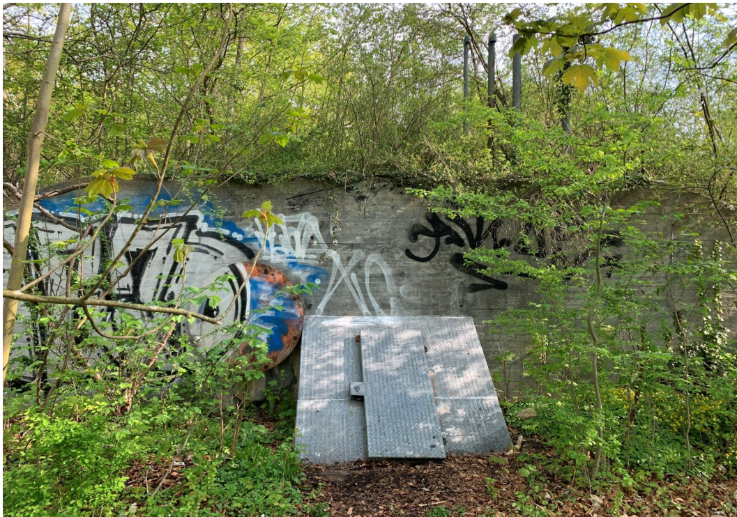
Figur 3: Den kärnvapensäkra bunkern. Foto: författaren (2021-05-11).
