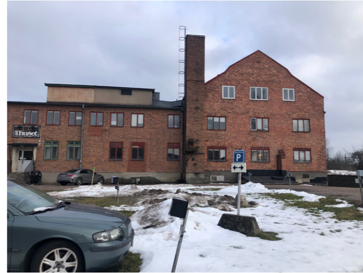
Slaktlokalerna, idag kulturhus, är en av de byggnader som ska sparas
