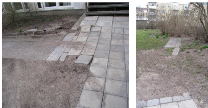
Dålig markbeläggning försvårar framkomligheten samt skapar olycksrisk på Kungsängsgården.
