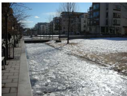
Öppet dagvatten system i Hammarby Sjöstad
