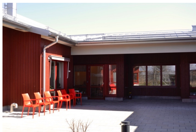
Figur 23 Vy över den delvis regnskyddade terrassen. Av: Wilma Johnte, 2021
