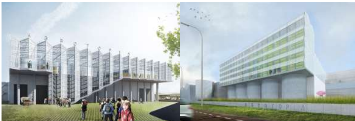
Figur 12 Agrotopias fasadväxthus från två olika håll. Betongsilosarna innehåller näringsbevattningen.
