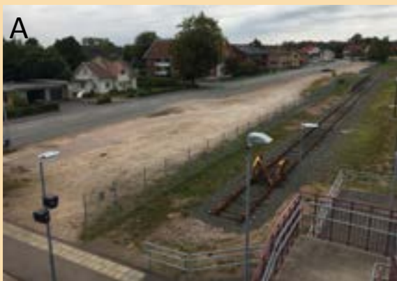
Bild A. Norra delen av stråket. Spårområdet avskärmas med staket mot grusyta. På motsatt sida av Järnvägsgatan ligger villaträdgårdar.
