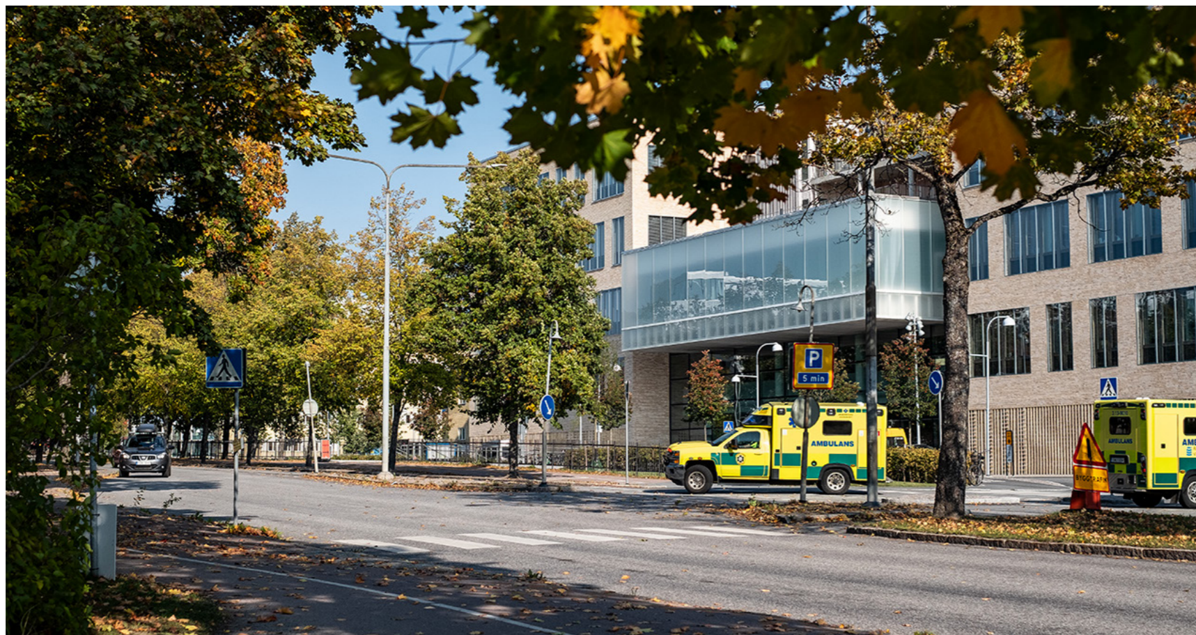
Figur 18. Vy mot Akademiska sjukhuset ingång 100/101 samt Dag Hammarskjölds väg - biltrafik och ambulanser skapar en intensiv ljudbild.
