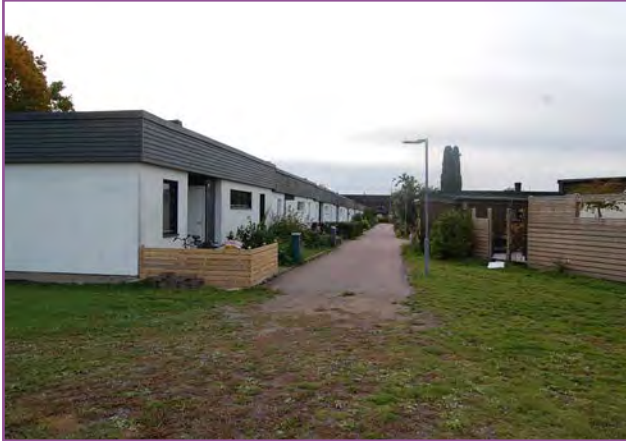
Figur 109. Möjlighet: ett exempel på anslutning ut mot spåret (smal asfaltsgata). Det finns många sådana här entréer ut mot stråket i Årsta. Här finns möjligheter att skapa nya kopplingar till ett eventuellt nytt spår:
