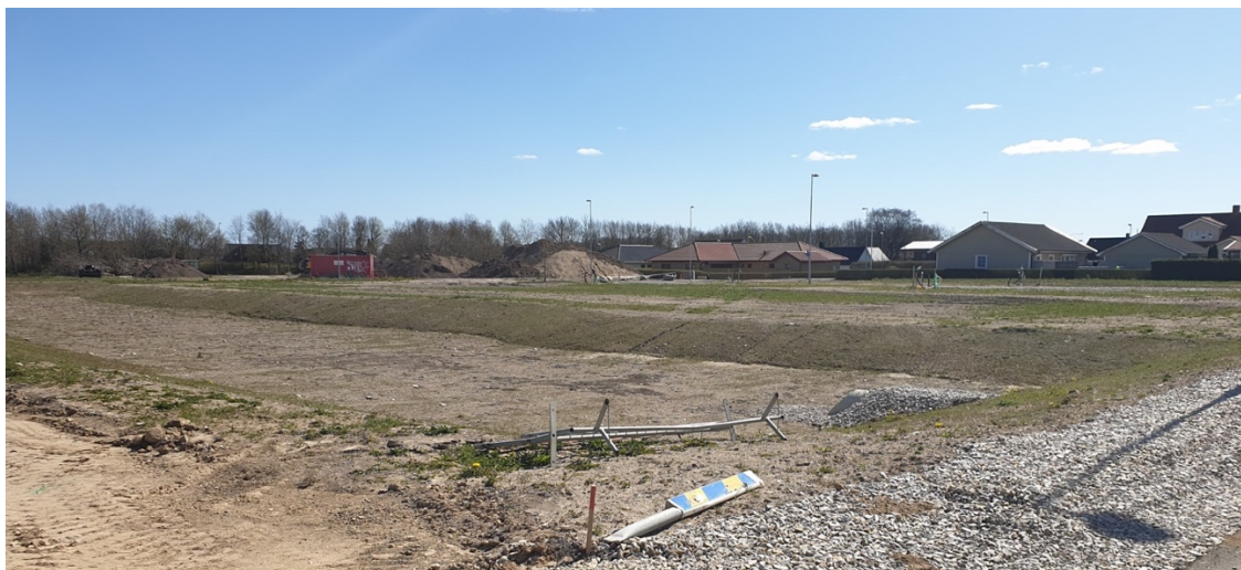
Bild 2. En pågående dammanläggning i Karlsborgsområdet.
