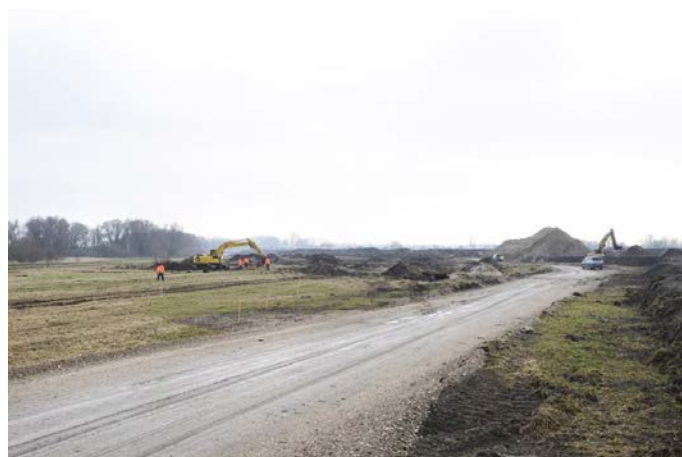
Figur 2: Pilotprojekt_Kreetsand08.jpg (IBA Hamburg / Martin Kunze u.å) Anläggning av Kreetsand.
