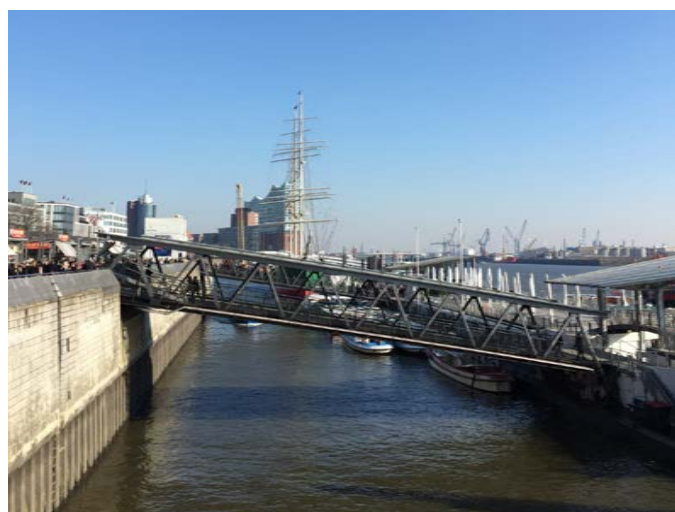
Flytbryggor åtkomlig med gångbroar.
