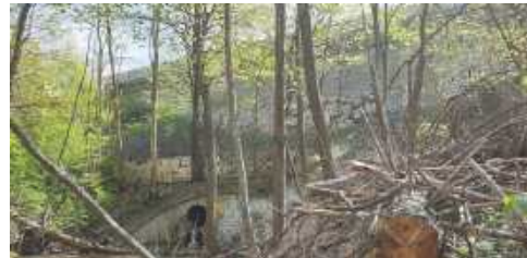
Figur 9. Kulvert och muren på Vårbysidan.
