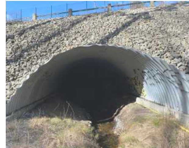
Figur 52. Vägtrumman under E4/E20
