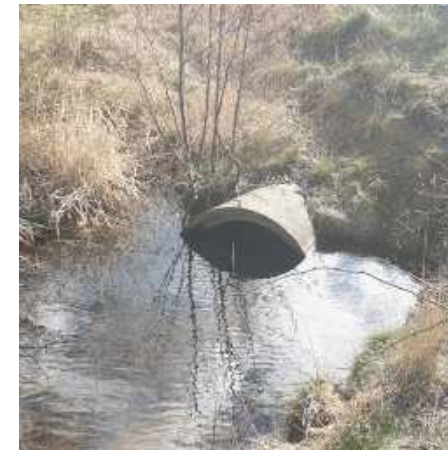
Figur 18. Kulvert under Vårby Allé
