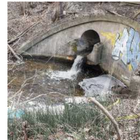
Figur 22. Kulvert under E4/E20
