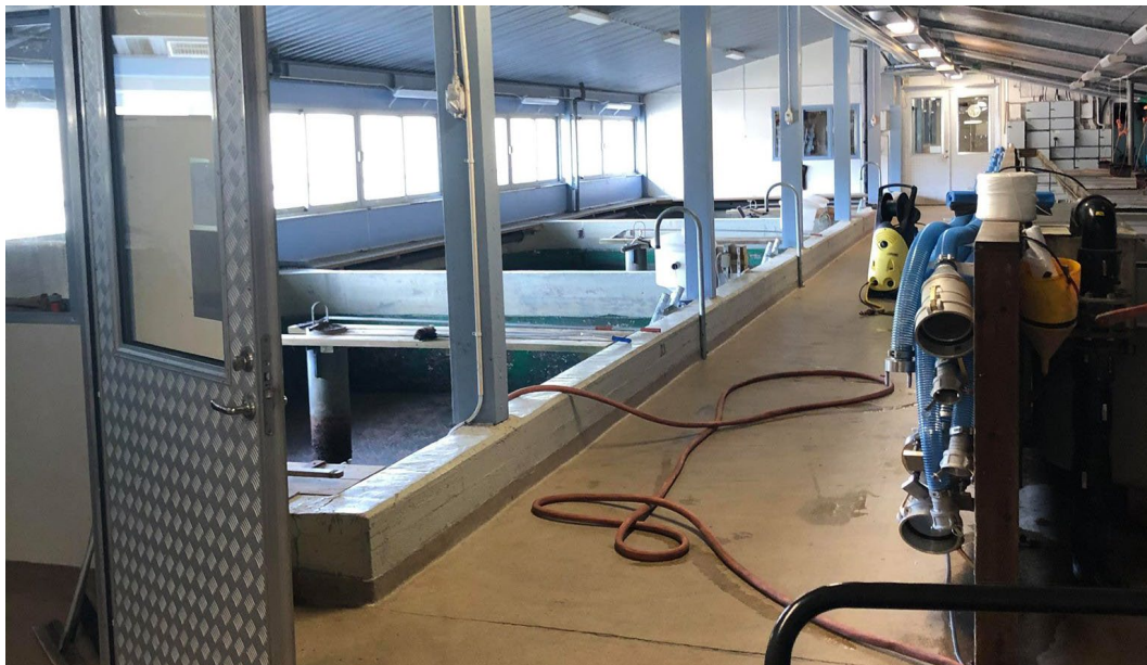
Figur 2. Till vänster skymtar D-tråg (42 kvm) tillverkat i betong. Foto: Sofia Nymans
