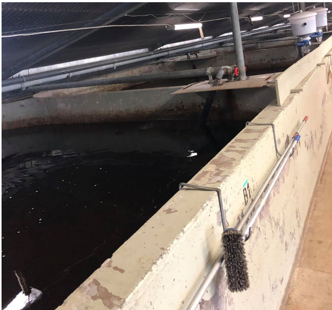
Figur 3. Ett B-tråg (23 kvm) tillverkat i betong. Foto: Sofia Nymans
