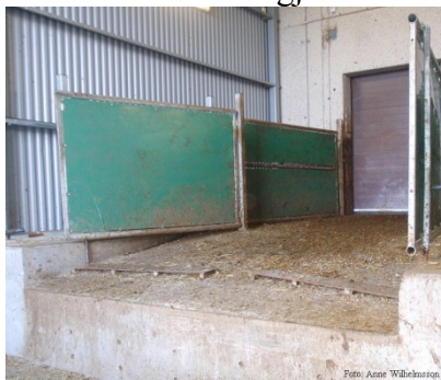
Bild 1. Den fasta avlastningsrampen på slakteriet.
