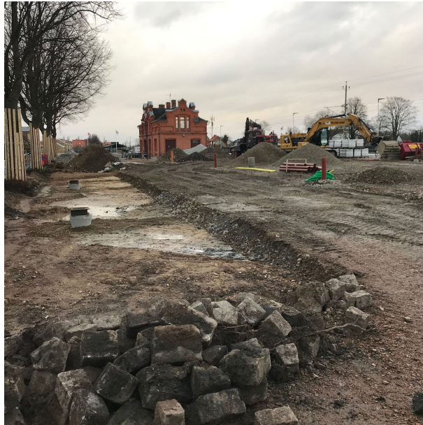
Figur 12. Arbetsplatsdisposition. Lomma station. Bilden visar ombyggnation av markbeläggning, där gatstenen skulle kunna återanvändas på plats.
