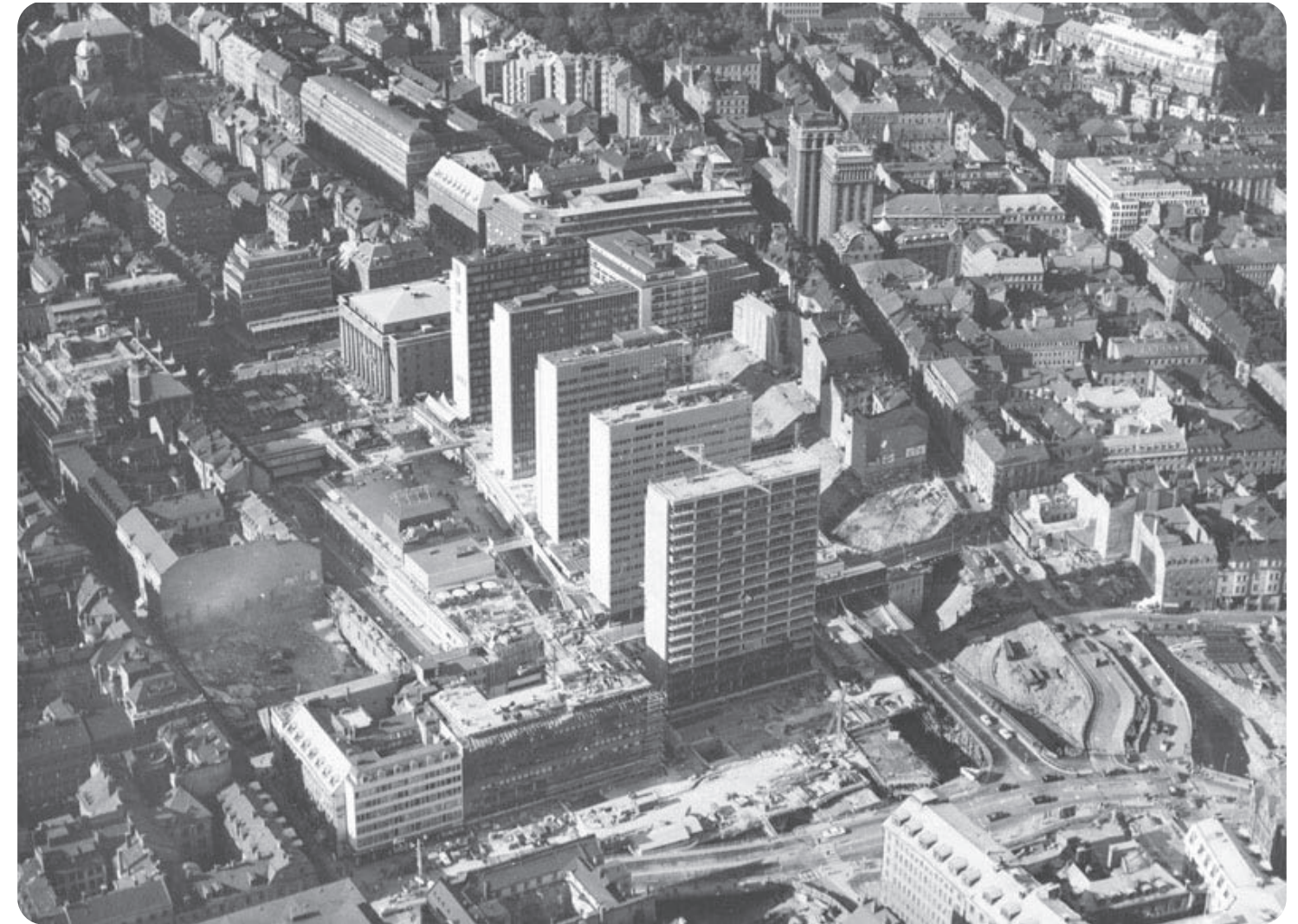
Figur 7. Bild från ovan som visar Sergels torg, i bildens nedre mittkant, som precis anläggs och Klarakvarterens hus som står i ruiner i väntan på att ersättas. Mitt i bilden står Hötorgskraporna. ©Oscar Bladh 1961
