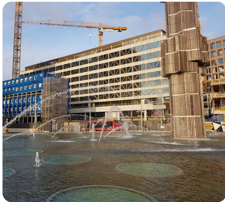
Figur 9. Främst i bilden syns fontänen, till höger i bild står glasobelisken som utgör fontänens mitt och i bakgrunden syns byggarbetsplatsen där Vasakronan bygger om kvarteret Hästskon.
