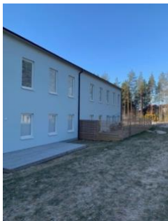
Figur 1: Bild som visar de nybyggda huset med övertäckta fönster mot parken. (Hane 2019)
