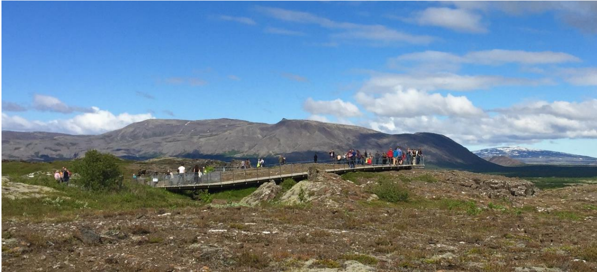
Bild 1. Bilden visar ett exempel på en tillgänglighetsanpassad däckspång över ett stenigt parti med känslig vegetation som möjliggör både skydd för naturvärden samt åtkomst för människor.
