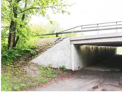
Figur 6: Vy 3. Materialmöte av asfalt, grusig jord, dekorplatta, sten och betong. Öppningarna nås av naturligt ljus och borde kunna förstärkas med grönska. Här finns planteringsytor och plats för att bygga upp växtbäddar. Fotot är taget 26/5-19 kl.15.30. (Lindeberg 2019)
