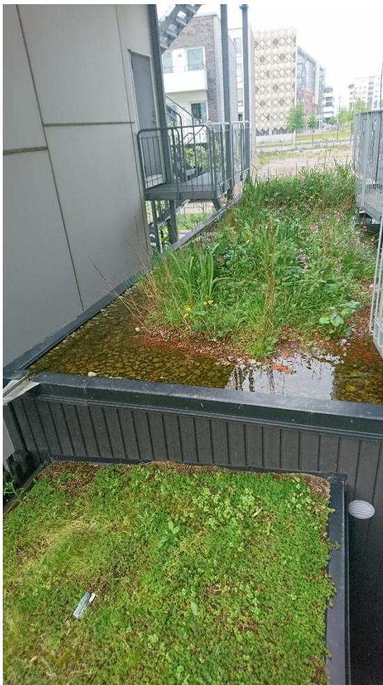
Fig 6: Exempel på vattentillägg vid Cykelhuset Ohboy, Malmö. Foto: Petra Niskanen.
