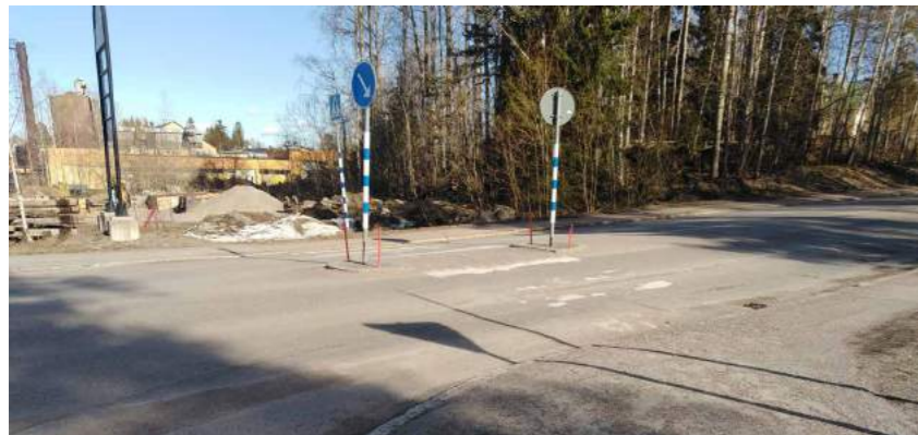
Figur 42: Bilden visar övergångsstället vid Bruksvägen som saknar hastighetsbegränsande åtgärd. Längs med Bruksvägen tillåts bilarna köra i 50 km/h. Generellt i arbetsområdet saknas övergångsställena markeringar i markmaterialet för personer med nedsatt orienteringsförmåga.
