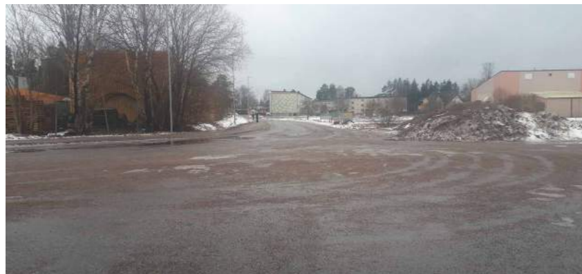
Figur 43: Bilden visar kurvan vid Stationsvägen vid stationsområdet. Markmaterialet är helt i asfalt och det saknas övergångsställe eller annan vägledning om hur man ska ta sig över till trottoaren på andra sidan på ett trafiksäkert sätt.
