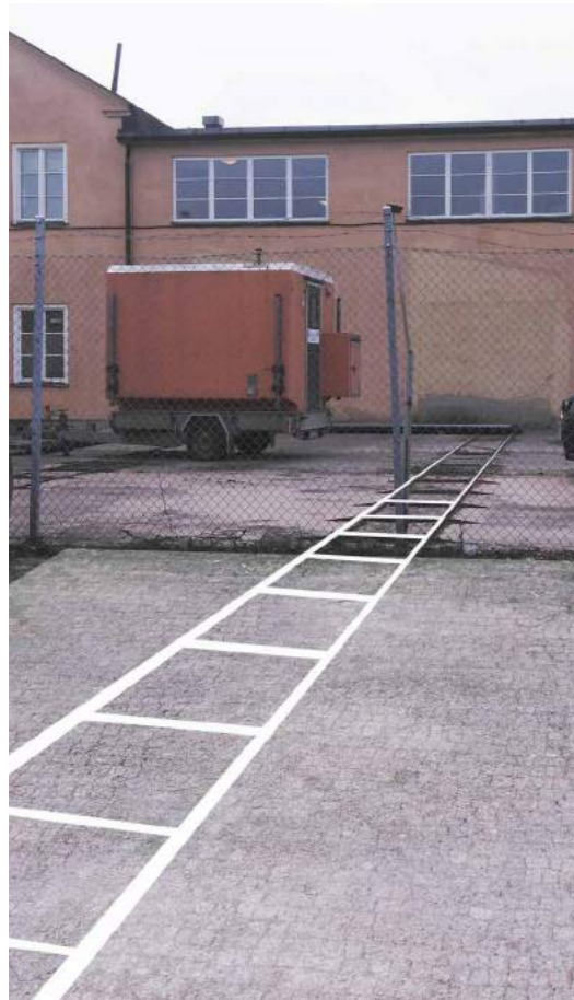
Figur 71: Bilden visar hur den äldre tågrälsen "fortsätter ut" i markmaterialet.
