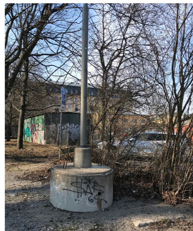
Figur 31: Tillfällig belysningsstolpe längs Hovslagargatan, 2019.
