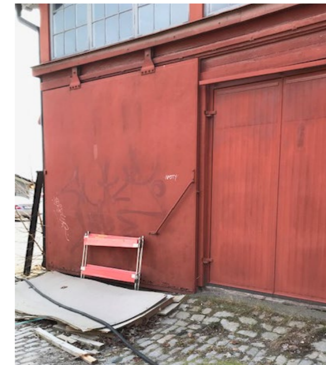
Figur 25: Skräp och byggrester utanför ett av Hammagasinen och klotter på fasaden, 2019.
